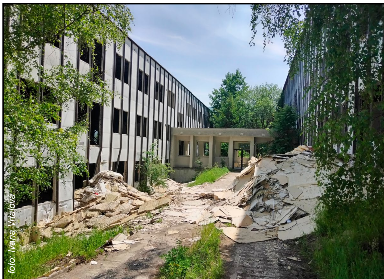
Ubytovna A a B se spojovacím krčkem, ještě s obvodovým pláštěm systému „KORD“ (ocelová montovaná nosná konstrukce)
