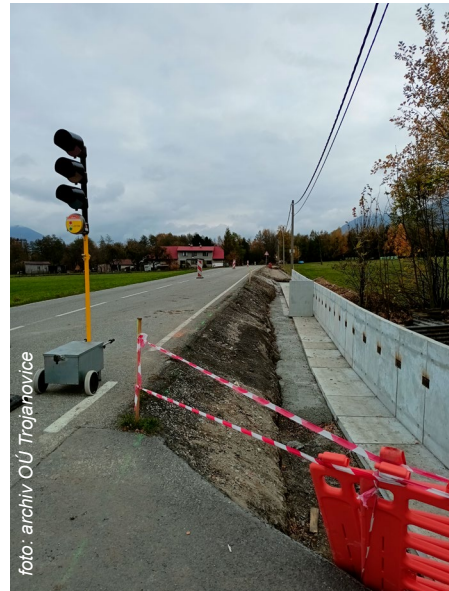
V podzimních týdnech se podařilo dokončit betonáž opěrných zdí
