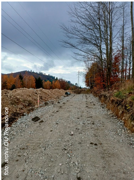
Zemní práce pokračovaly přípravou podkladových vrstev po již téměř celé trase nového cyklokoridoru.
