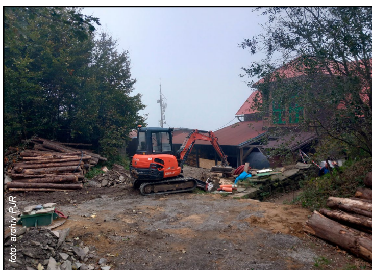
Realizace vrtané studny na Velkém Javorníku v letech 2023-24
