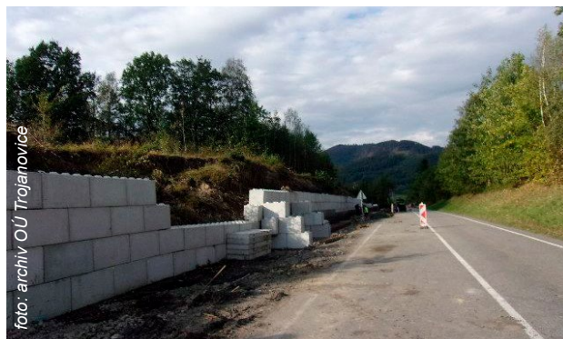
Legobloky zpevňující odbagrované svahy
