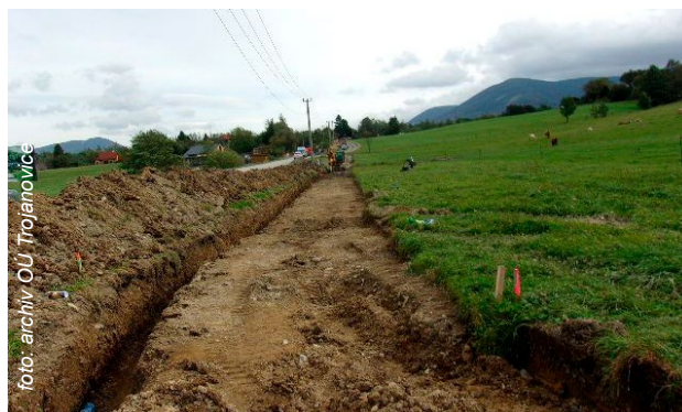
Zemní práce na koridoru cyklostezky pod Radhoštěm
