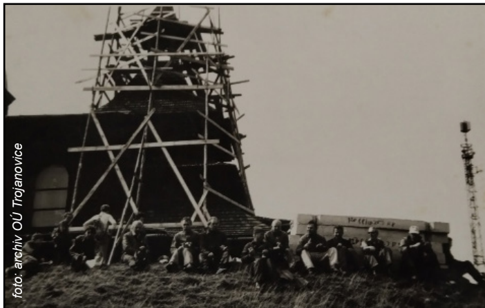
Oprava zvonice 1982 - Československá strana lidová - Trojanovice - organizátor Jan Tichavský*
