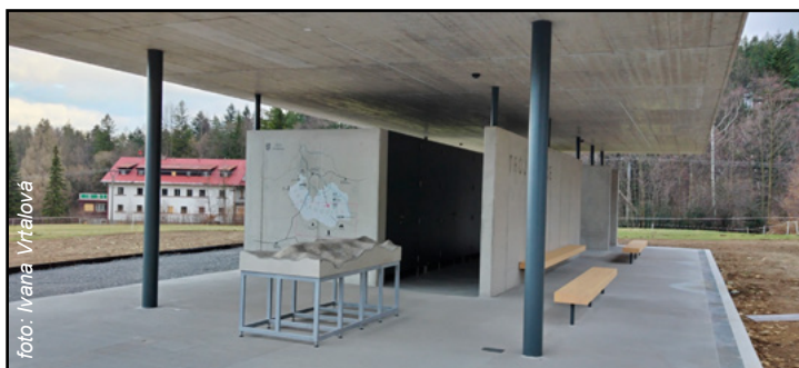
Zázemí parkoviště Koksář před dokončením
