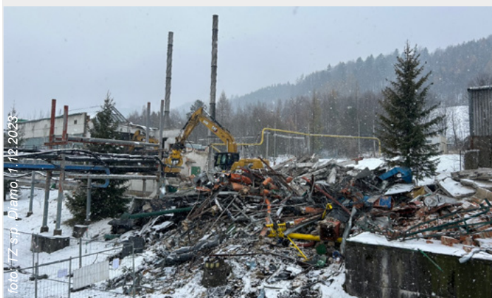
Likvidace pozemních staveb je rozdělena na tři etapy
