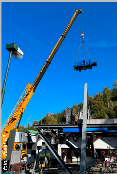
Demontáž hlavní převodovky jeřábem
