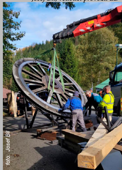
Ukládání lanového kotouče na speciální konstrukci pro přepravu
