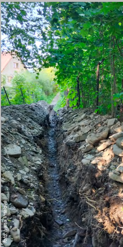
Výstavba vodovodu Za Lomnou
