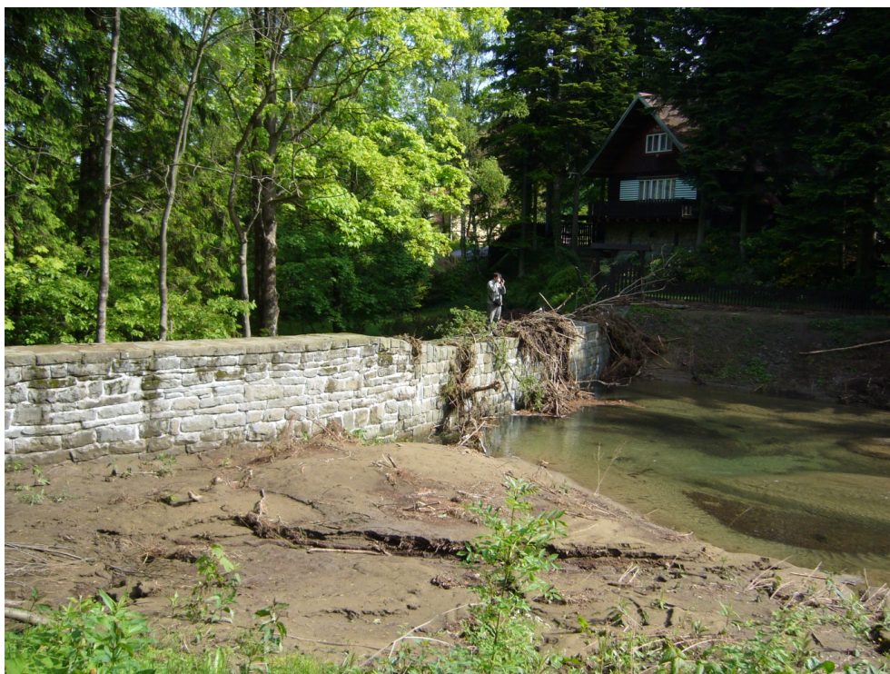
Obr. 39 Příčný stupeň, přehrážka na Lomné (říční km 6,492) v Trojanovicích ( srpen 2010).
