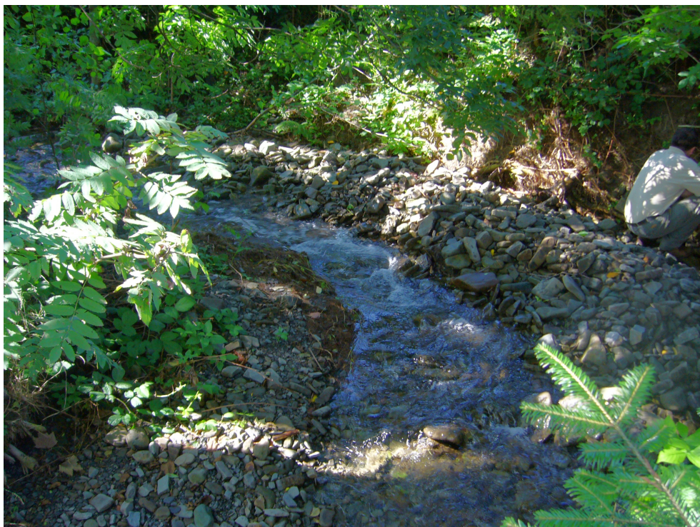
Obr. 29 Trojanovice - koryto Malého Škaredého potoka po povodni 2010.
