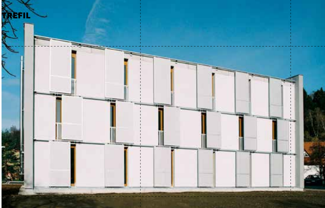
02 Dům na půl cesty – bytový dům, Valašské Meziříčí projekt 2003, realizace 2005 Projekt bytového domu, oceněný Grand Prix Obce architektů 2005 jako nejlepší novostavba v ČR a 1. cenou v soutěži realizovaných bytových staveb MMR v kategorii „bytový dům“ v roce 2005, k nalezení v celé řadě odborných publikací – Tipologija večstanovanjskih stavb, Architecture V4 a dalších.
